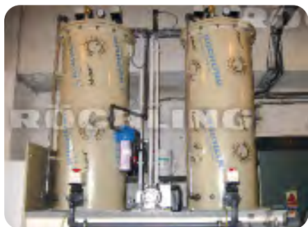
Polystone® Р гомополимер серый Очиститель отработанного воздуха
