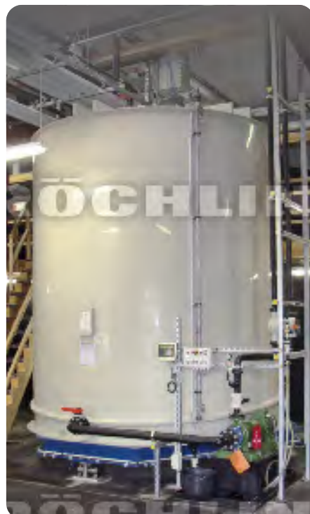
Polystone® P гомополимер серый Смесительная ёмкость (резервуар) объёмом 25 м³
