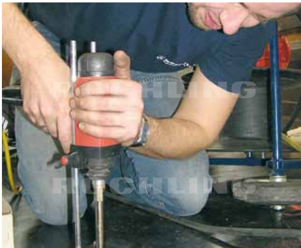
Retenção segura: Os pernos são soldados à base através das placas pré-perfuradas.
