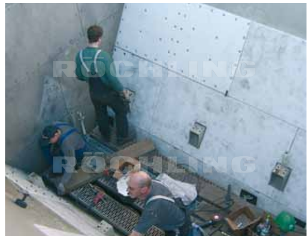
Procedimento de soldadura de pernos: Revestimento de um depósito.
