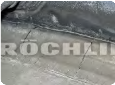
Fissuras por tensão
