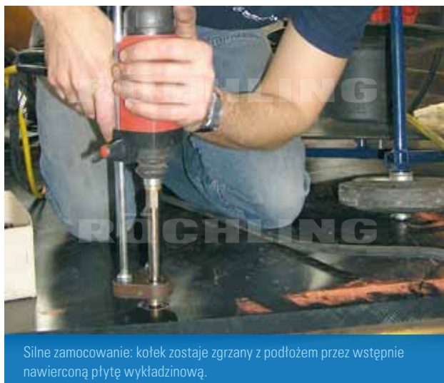
System mocowania z kołkami zgrzewanymi doczołowo.
