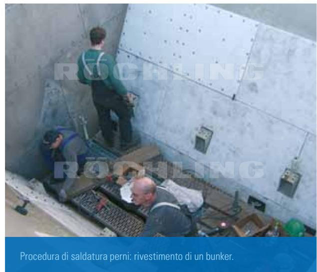
Procedura di saldatura perni: rivestimento di un bunker.
