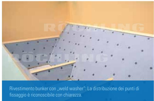
Rivestimento bunker con „weld washer“: La distribuzione dei punti di fissaggio è riconoscibile con chiarezza.
