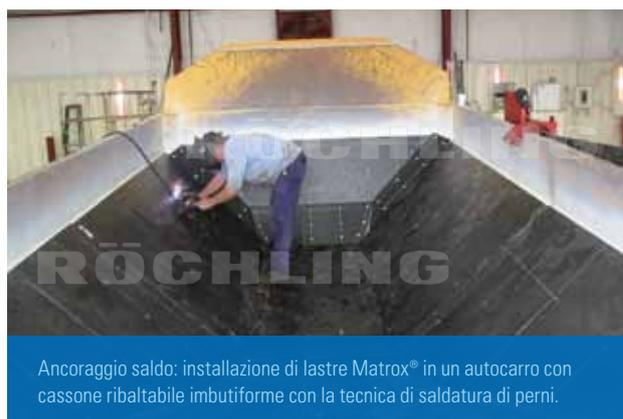
Ancoraggio saldo: installazione di lastre Matrox® in un autocarro con cassone ribaltabile imbutiforme con la tecnica di saldatura di perni.
