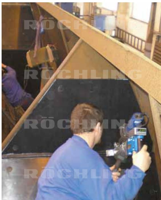
Saldatura del rivestimento di un vagone merci: Matrox® viene saldato ai bordi angolati per evitare che del materiale sfuso si depositi negli angoli.
