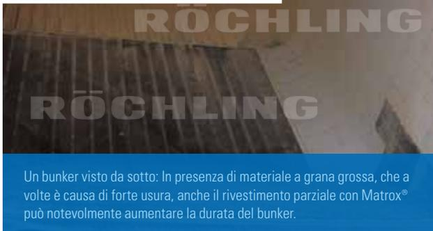
Un bunker visto da sotto: In presenza di materiale a grana grossa, che a volte è causa di forte usura, anche il rivestimento parziale con Matrox® può notevolmente aumentare la durata del bunker.
