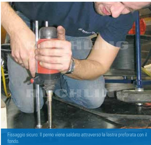
Fissaggio sicuro: Il perno viene saldato attraverso la lastra preforata con il fondo.
