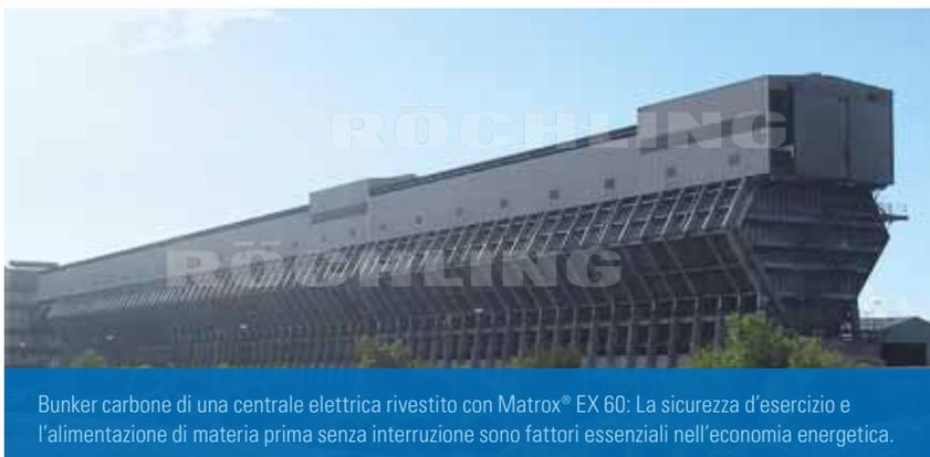
Bunker carbone di una centrale elettrica rivestito con Matrox® EX 60: La sicurezza d'esercizio e l'alimentazione di materia prima senza interruzione sono fattori essenziali nell'economia energetica.
