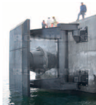
Défense sur un mur de quai
