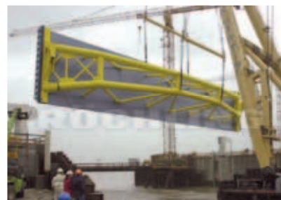
Écluse avec glissières
