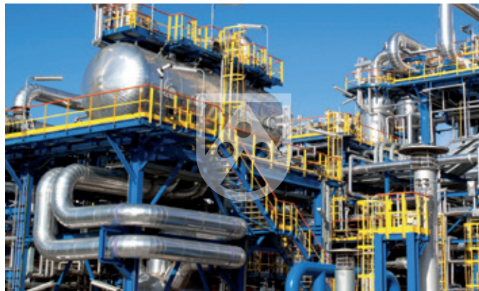
Construction d'installations chimiques Chemical plants
