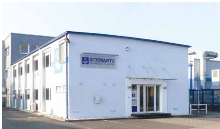
Neu bei Röchling Industrial: Die Schwartz GmbH Technische Kunststoffe, die jetzt unter dem Namen Röchling Industrial Xanten GmbH firmiert
